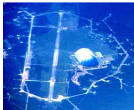
◀ Hangár a dráhy bývalého letiště jsou patrné i z letové výšky dopravních letadel. Na panoramatickém snímku je v horní části patrná dálnice z Drážďan do Berlína i dálniční křižovatka k hangáru
