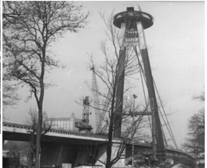
◀ Zesílení kotevních lan mostu v Bratislavě (Zdroj: ÚAM)
