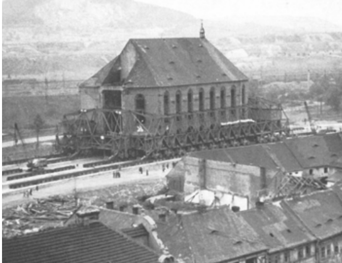
◀ Přesun kostela v Mostě (Zdroj: ÚAM)
