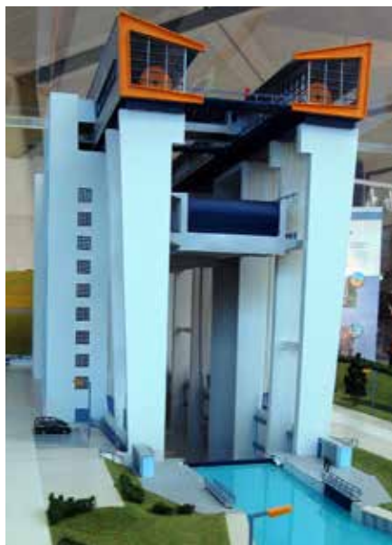
➤ Zdvížená vana mezi nosnými pilíři 65 m vysoké konstrukce na modelu Niederfinow 2 v Infocentru
