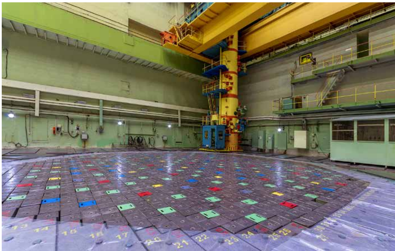
◀ Sklad použitého paliva JE Dukovany po 25 letech provozu elektrárny (Zdroj: ČEZ) – vlevo
