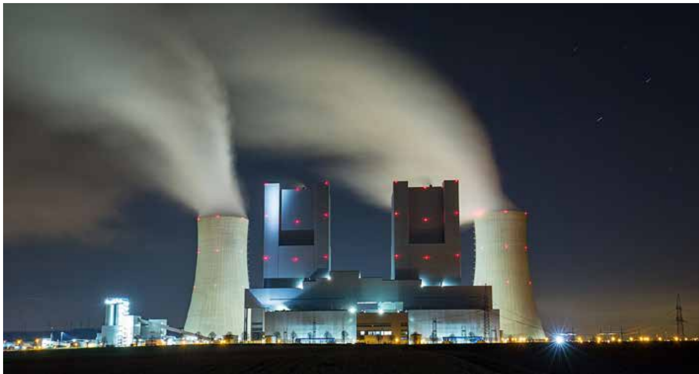
◀ Německá hnědouhelná elektrárna Neurath (zdroj Adobe Stock)
